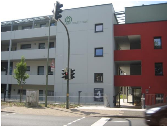
Haupteingang zur Braker Straße
